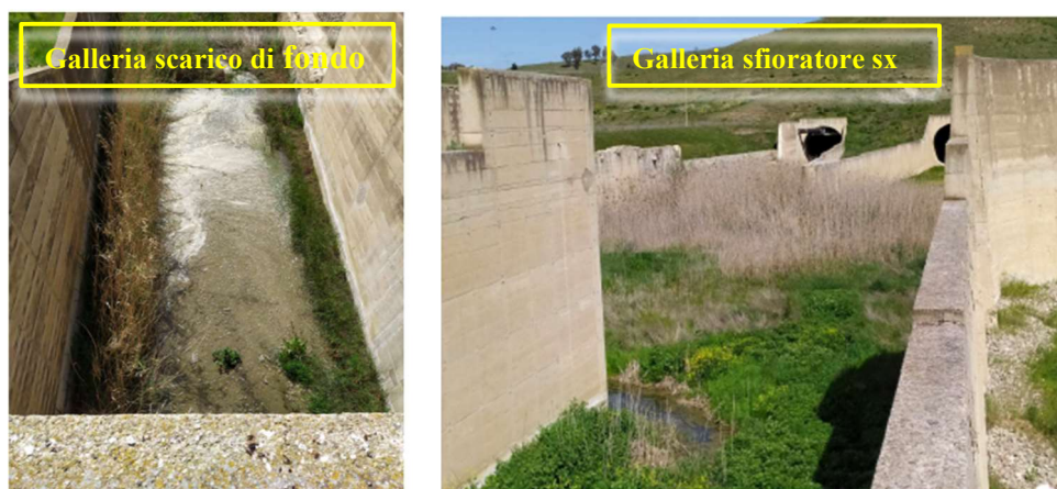
Figura 6-1: Diga di Gibbesi – Galleria scarico di fondo e galleria sfioratore sx - Presenza d'acqua e di alta vegetazione
